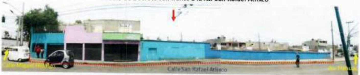
Predio de Decreto con frente a la Av. San Rafael Atlixco
