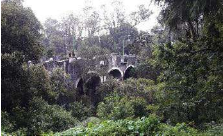
Fotografía 2. Puente en Barranca de Barrilaco
