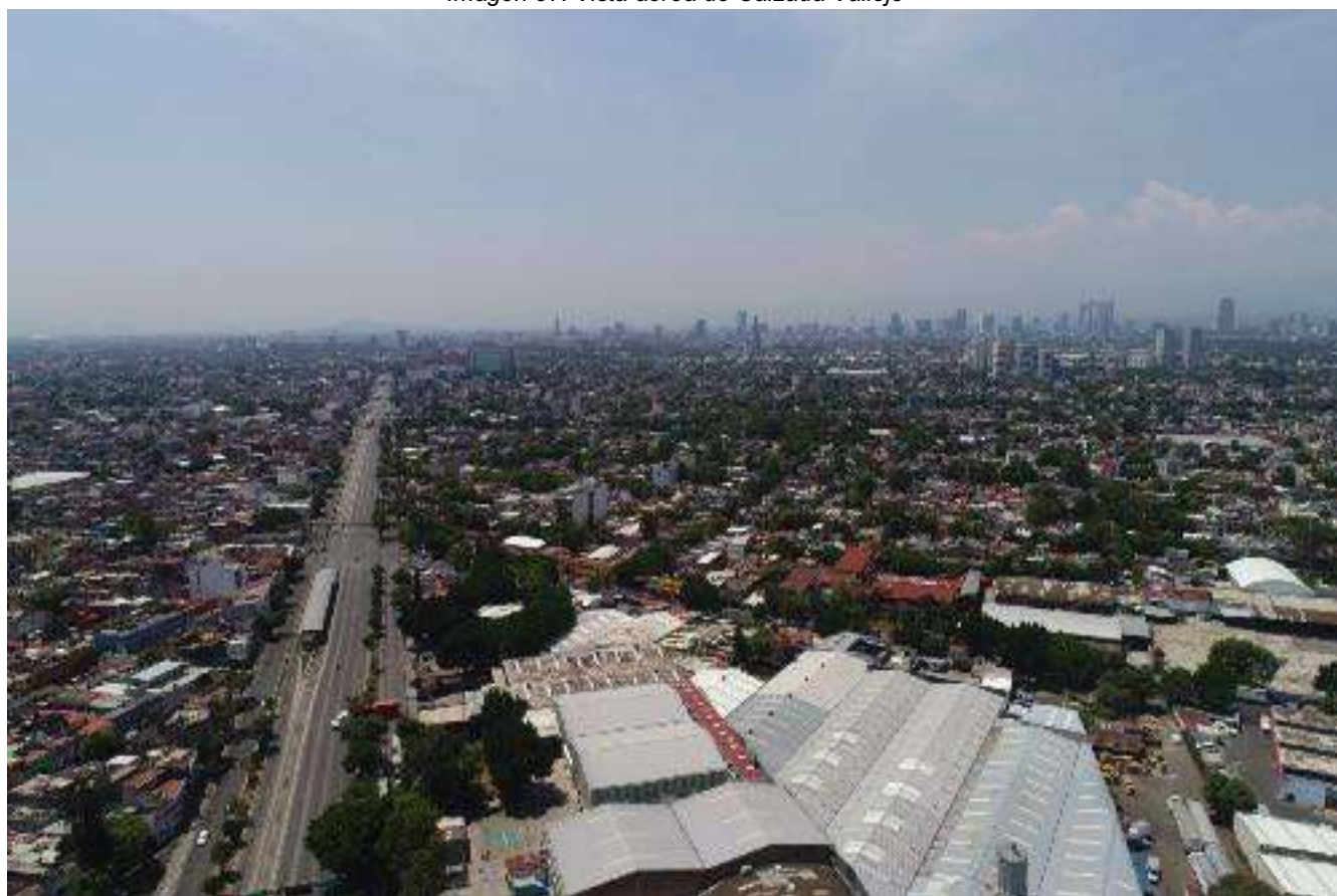
Imagen 57. Vista aérea de Calzada Vallejo
