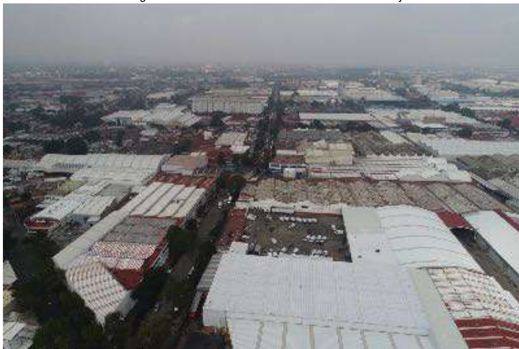
Imagen 32. Vista aérea de naves industriales en Vallejo
