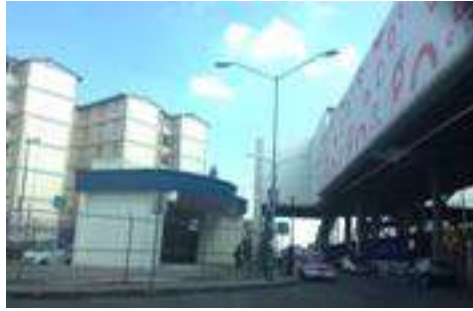
Imagen 50. Estación Fortuna y conjunto habitacional colindante
