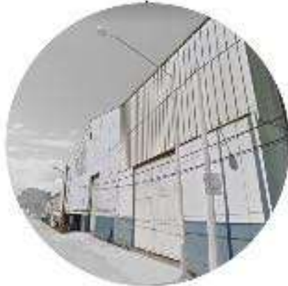
Predios en desuso (Poniente 148).
