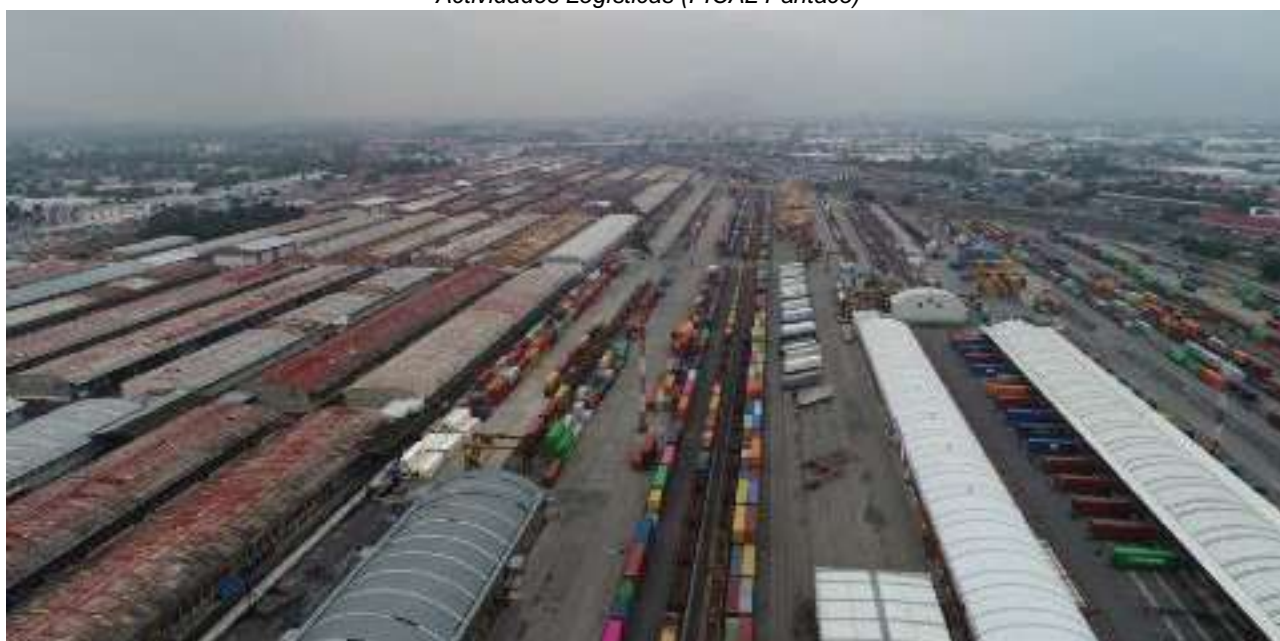
Imagen 83. Vista aérea del Ferrocarril y Terminal del Valle de México, Ferrovalle Intermodal y el Puerto Interno y Centro de Actividades Logísticas (PICAL Pantaco)
