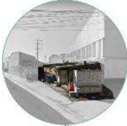
Asentamientos irregulares sobre vías en desuso.
