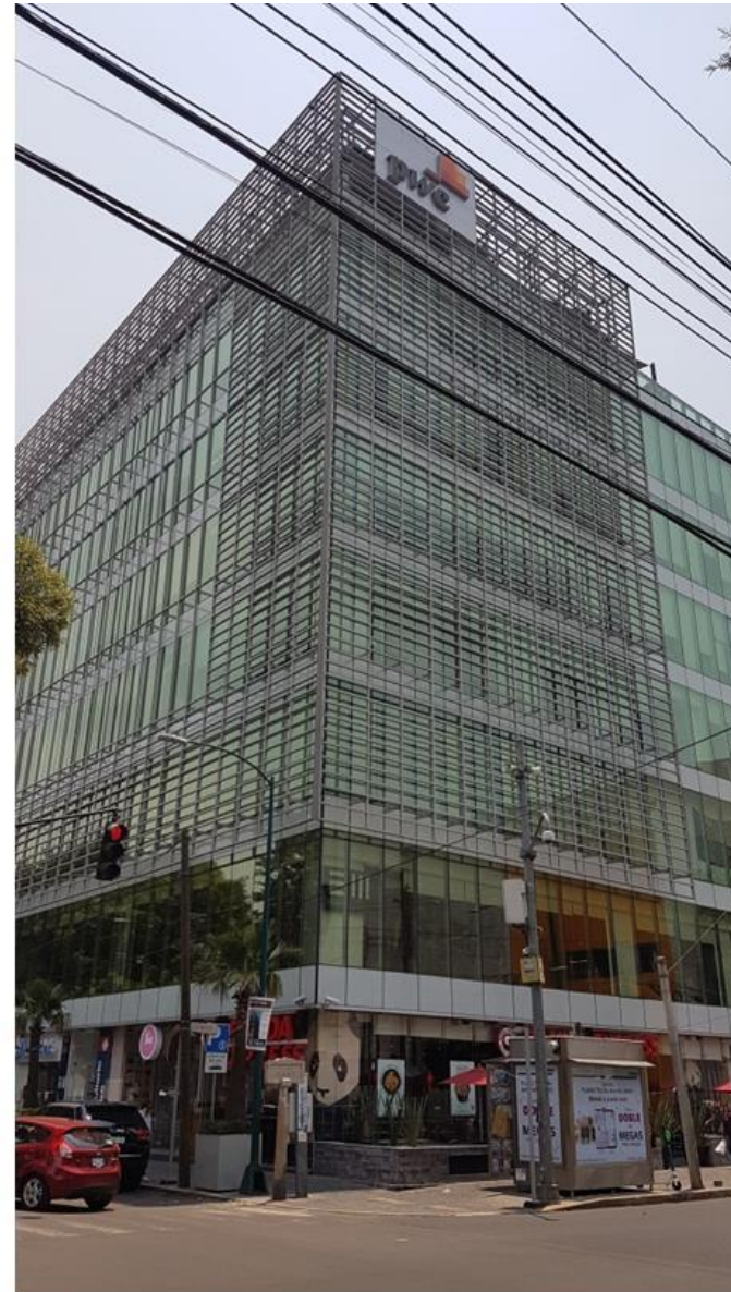
Foto 30.- Leibnitz No. 117, Edificio de Oficinas y Comercio.
