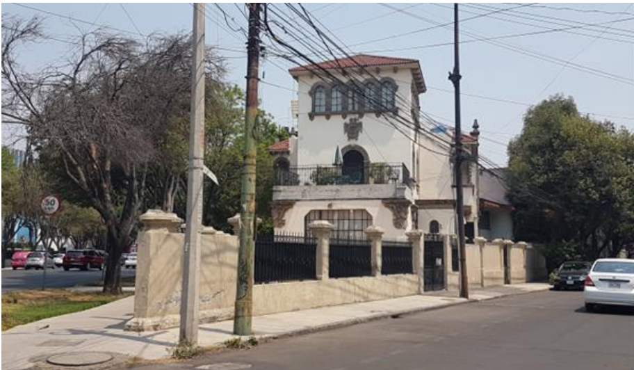
Foto 60.- Inmueble Desocupado. Av. Thiers No. 44.
