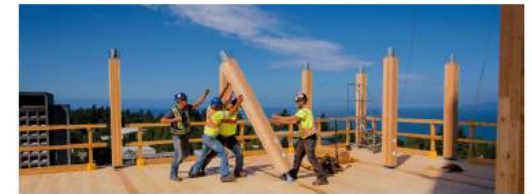
Residencia de estudiantes Brock Commons de la Universidad de Columbia Británica. Vancouver, Canadá 18 pisos, 53m de altura. 18 meses de construcción (70 días en construir estructura)
