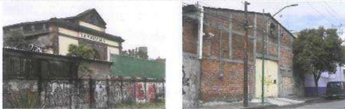
Ilustración 92 Antigua Fábrica "La Maravilla" y Edificio industrial en condiciones de degradación
