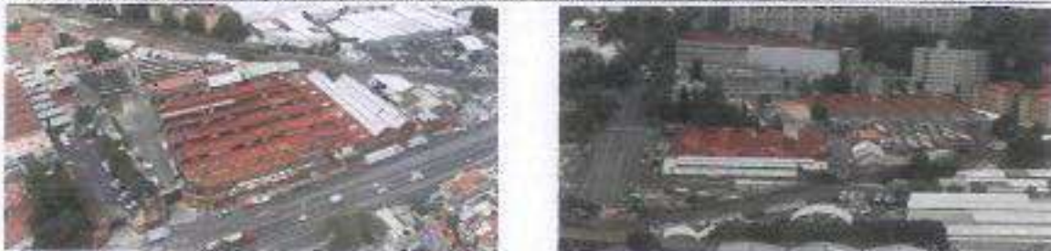
Ilustración 52 Cerillera "La Imperial": vista hacia Eje 2 Norte / vista a distancia con Ferrocarriles Nacionales.
