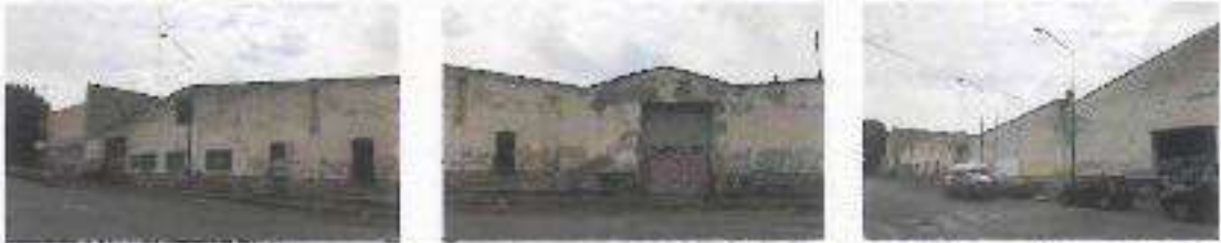
Ilustración 71 Ciprés No. 313: Instalaciones fabriles
