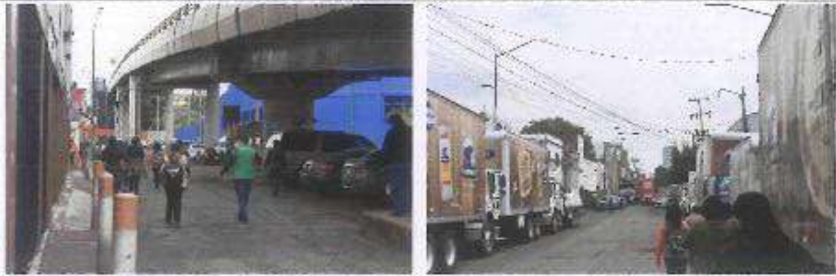
Ilustración 94 Condición actual de bajo puente / Calle obstructa por camiones de carga estacionados
