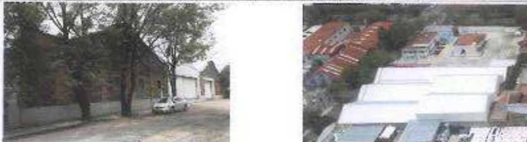
Ilustración 53 Inmueble en Fresno No. 376, Lote b: vista hacia calle Fresno / vista aérea.
