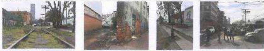
Ilustración 84 Calle Crisantema: vías de tren, espuelas y señalizaciones, asentamientos humanos irregulares.
